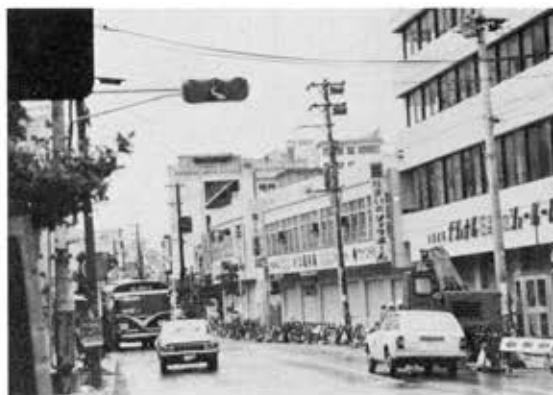
(b) 左側交通信号の設置及び関連道路工事状況
