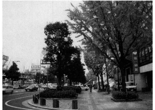
幅員50m。近年、シンボルロード事業により緩速車線が歩道に変更された。
