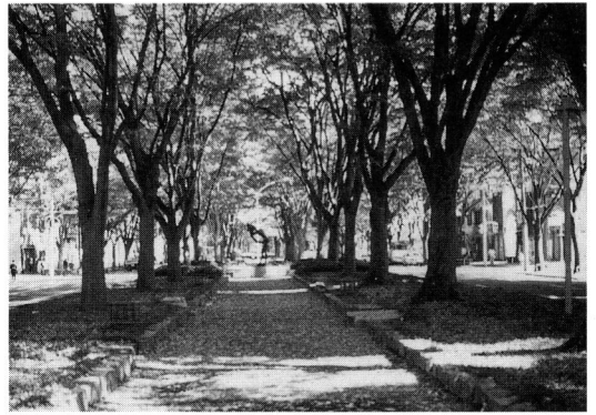
幅員46m。緑地帯は幅12m。戦災復興の際、電線の地中化まで実行されている。なお、Fig.6の内幸町通りを参照。
