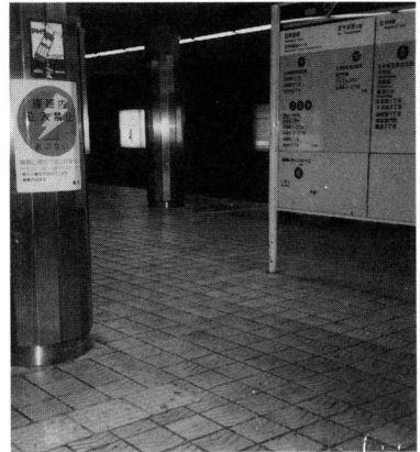
②これも誘導路と間違えると、途切れているため方向を見失うか、正面の案内板にぶつかる。
