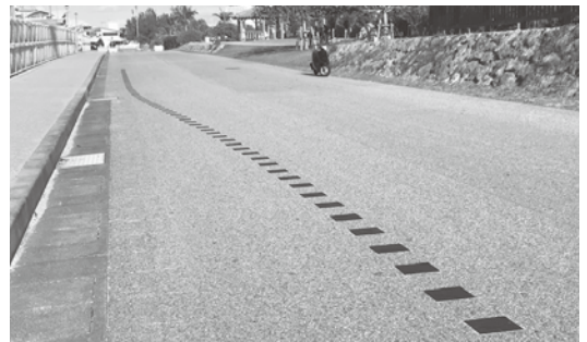
Fig.9 道路に設置された磁気マーカー: 黒いテープによって道路に固定されている
