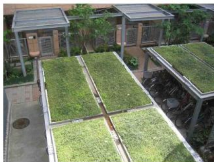
自転車置き場の屋上緑化例
