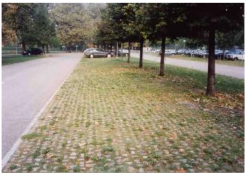
境の緑地と透水性芝生舗装
