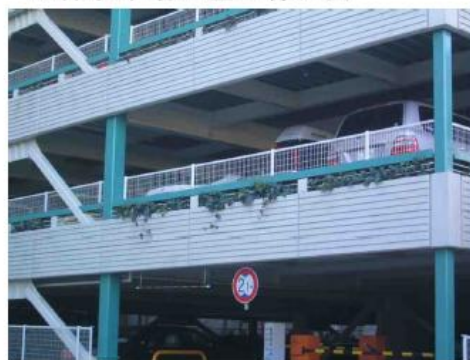
立体駐車場の緑化例
