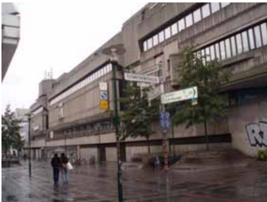
写真-2-29 都心部再開発ビル、地下に駐車場が用意されている
