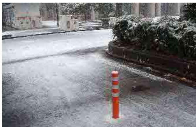
写真 4-2 : 降雪時のライジングボラード稼働の様子
