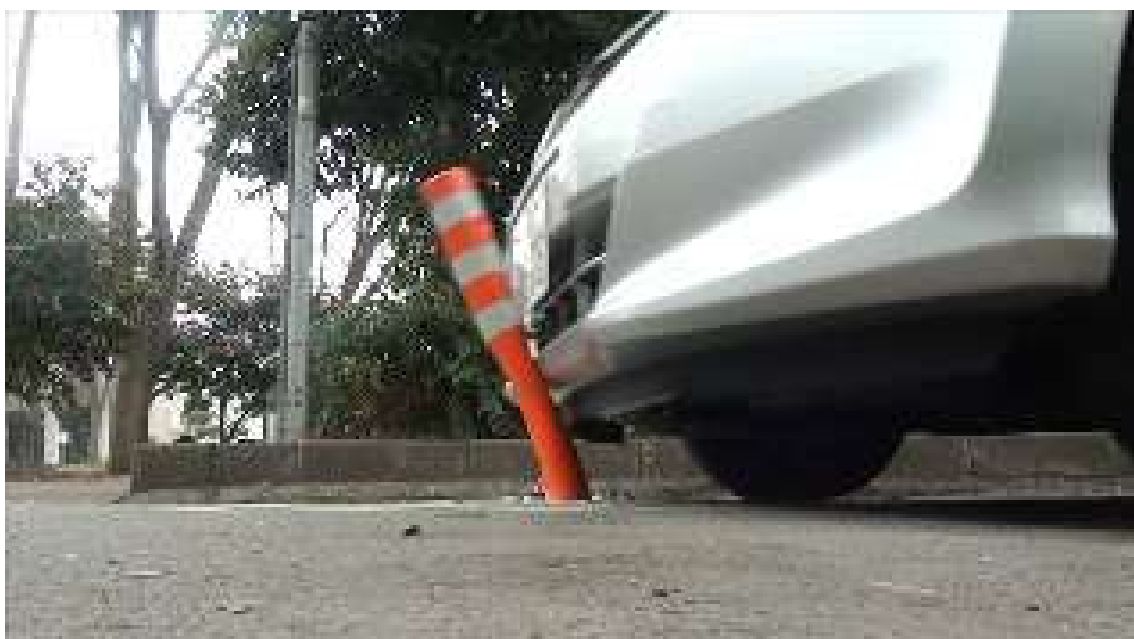
写真 4-11 車両によるボラード踏み倒しの様子
