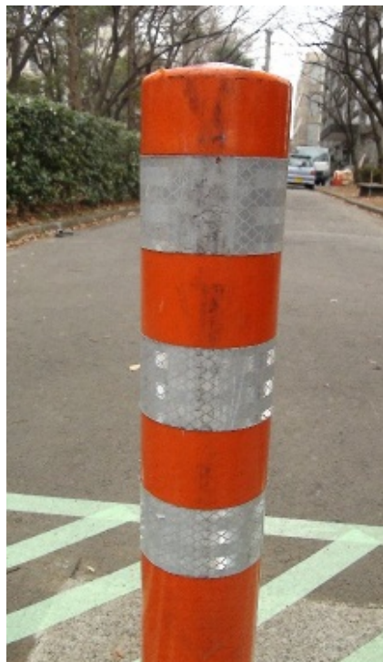
写真 4-14 踏み倒し後のボラード
