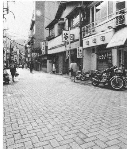
Fig. 5 ブロック舗装 Block pavement
