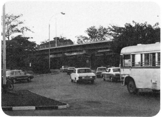
Fig. 4 立体交差点 A flyover
