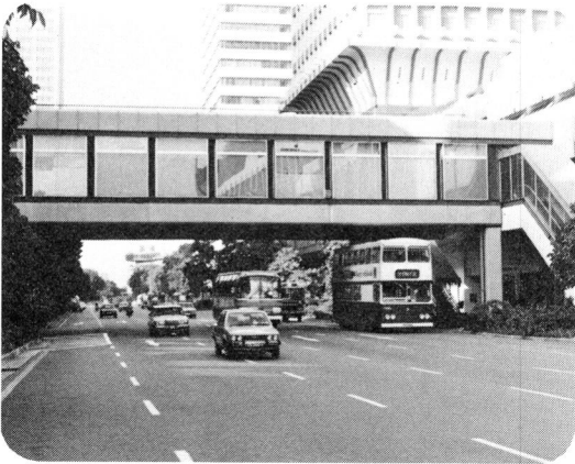
Fig. 9 ショッピング・ブリッジ A shopping bridge
