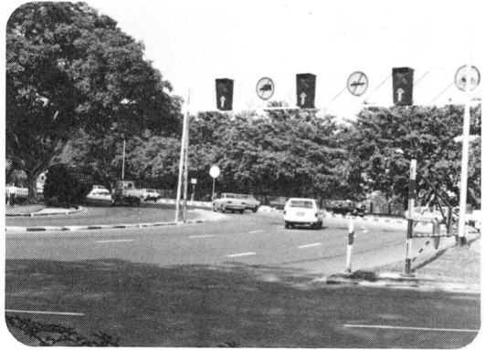
Fig. 3 切換車線 Reversible traffic lanes
