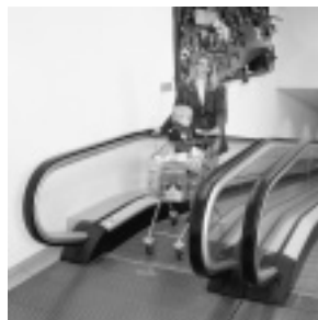
Fig. 7 傾斜型パレット式動く歩道の乗降部設置状況：ショートパレットの場合
