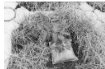
Fig. 4 ユニット苗施工状況
