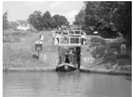
Fig. 7 高低差を越えるための水門
