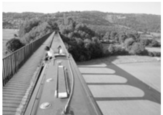
Fig. 17 ポントカサステ水道橋
