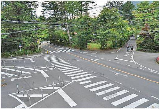
(a) 施工前 (平成24年)
