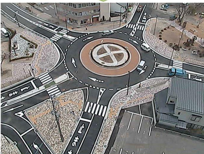
(c) 完成(平成25年3月)
