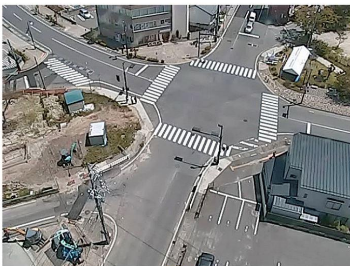
(a) 施工前(平成24年)
