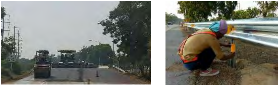
รูปที่ 8-4 งานติดตั้งของเครื่องหมายเตือนและเครื่องหมายถนน
