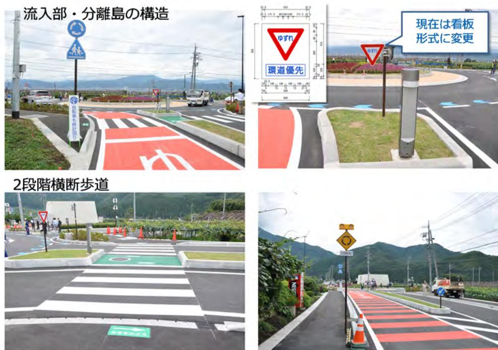
図-2.4 須坂市野辺町ラウンドアバウト 流出入部構造
