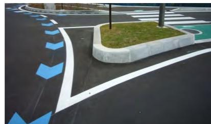
写真-C6.3.2 流出部の構造
