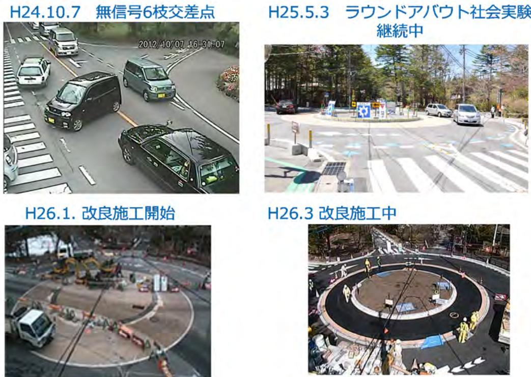
図-2.6 軽井沢町六本辻ラウンドアバウト 事前、社会実験時、改良施工中の様子
