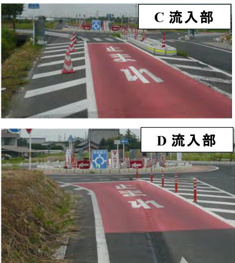
図-C5.3.2 流入部車線幅員の狭小化と主道路の市道笠原立田線への段差舗装
