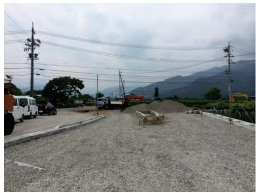
図-C6.5.1 排水施設の整備、土工基面整成（左写真提供：須坂市）
