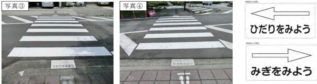
図-C1.4.3 横断歩行者用注意喚起のための路面標示シートの設置例
