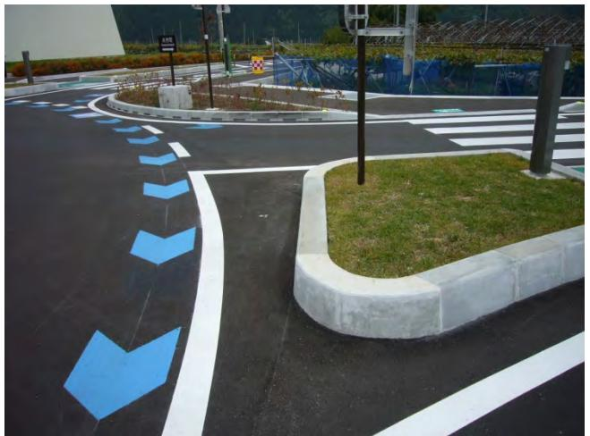
図-C6.5.9 分離島(出入り部)の曲線処理(左:施工中、右:完成形)
