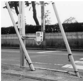
押しボタンのボックスが突き出ており、白杖では検知できないため、視覚障害者がこのボックスに衝突する危険性がある。
