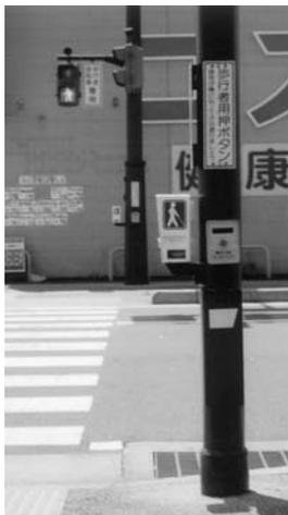
Fig. 15 横断歩道部分を示す点字ブロックの端とボタンの位置に関する好事例（宮崎県延岡市）
