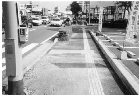
このケースでは押しボタンの手前まで誘導ブロックを敷設するとよい。さらに幅の広い横断歩道の場合には、何箇所かに車止めの支柱が設置されることが多いので、中央付近に設置される車止めに押しボタンをつける方法がある。
