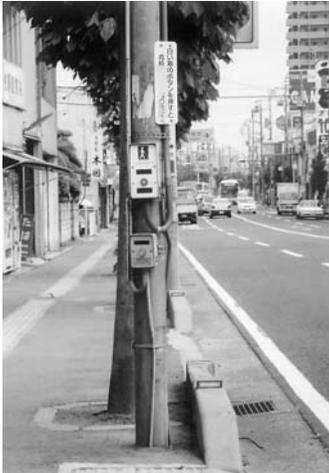
一般用の押しボタンが先に設置され、障害者用が後づけされたケースであり、位置の交換が必要である。
