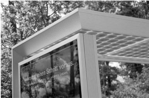
Wall社インテリジェントバストップの構造ディテール。大断面アルミ押し出し材を用いた精度の高いデザインは、快適なバストップを作る。
