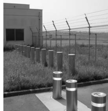
Fig. 6 車両進入防止杭の設置
