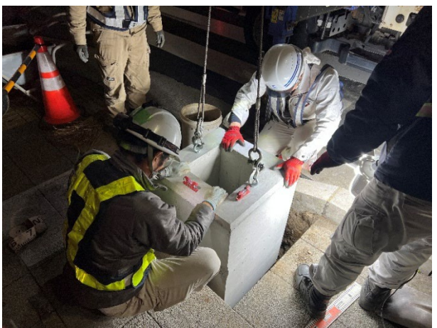
基礎部の施工
