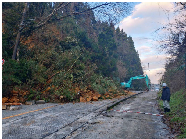
■ 斜面崩壊 → 応急復旧（崩土除去、大型どこのう設置、斜面手当）
