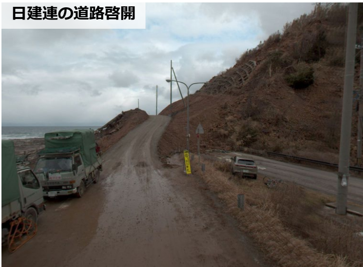
■ 斜面崩壊 → 応急復旧（崩土を乗り越え）
