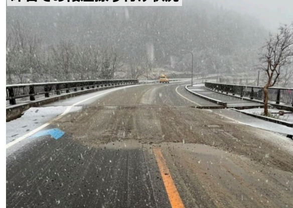
砕石での段差擦り付け状況
