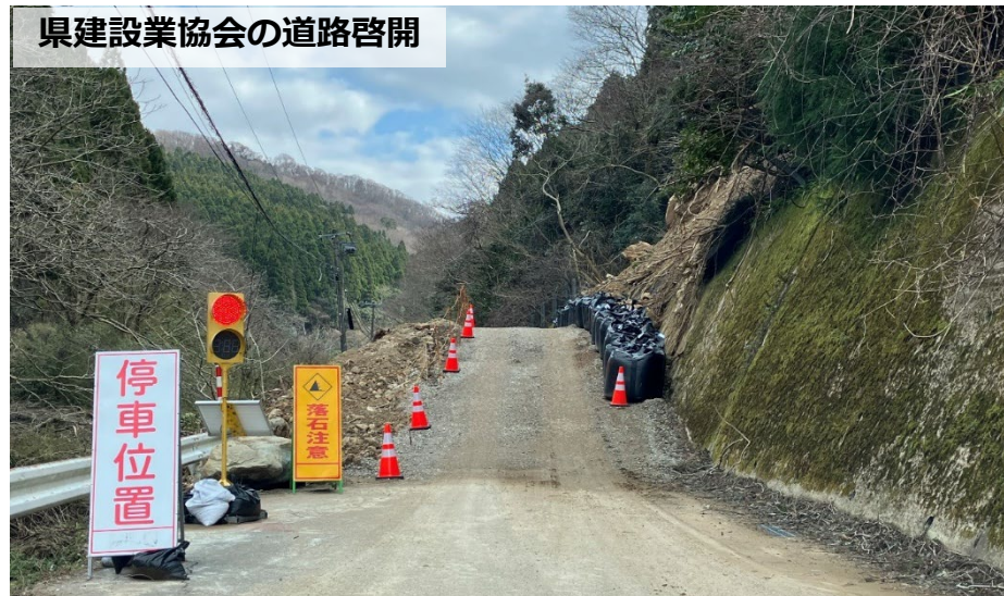
■ 斜面崩壊 → 応急復旧（崩土除去、大型どこのう設置、斜面手当）
