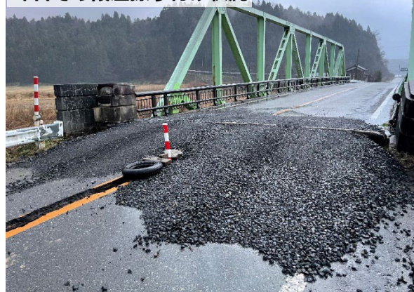
砕石での段差擦り付け状況
