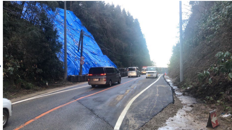
■ 斜面崩壊 → 応急復旧（崩土除去、大型どこのう設置、斜面手当）
