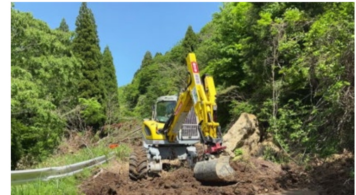
バケットによる掘削作業
