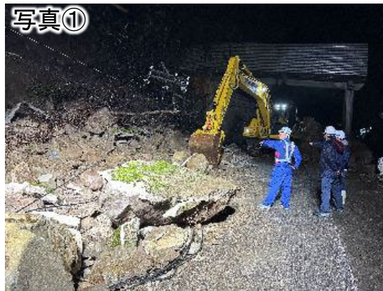
県道1号 輪島市三井町での啓開作業(1月3日撮影)
