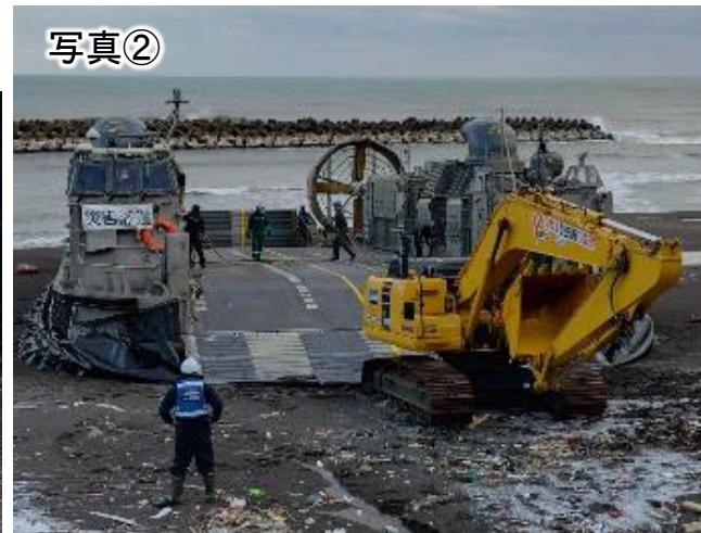
深見海岸 海側からの重機運搬(1月14日撮影)
