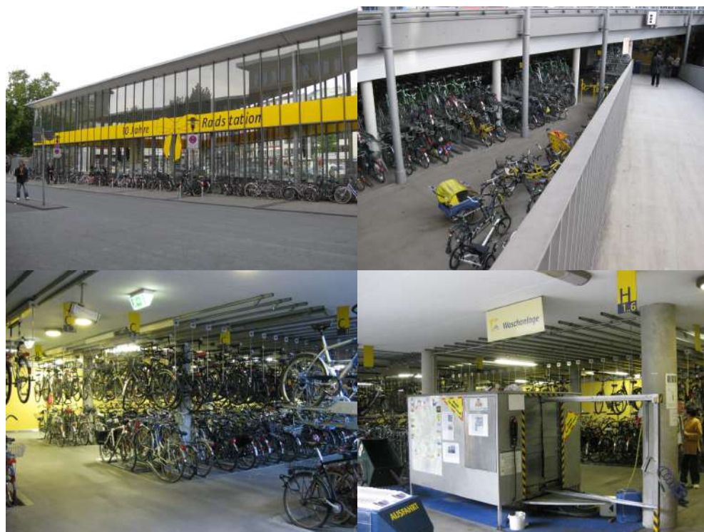
図 4-25 中央駅前自転車駐輪場 (左下写真の通り、収容はつり下げ式となっている。右下は洗車機械。)
