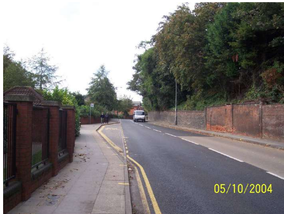
図 4-110 公園前の道路状況（整備前）
