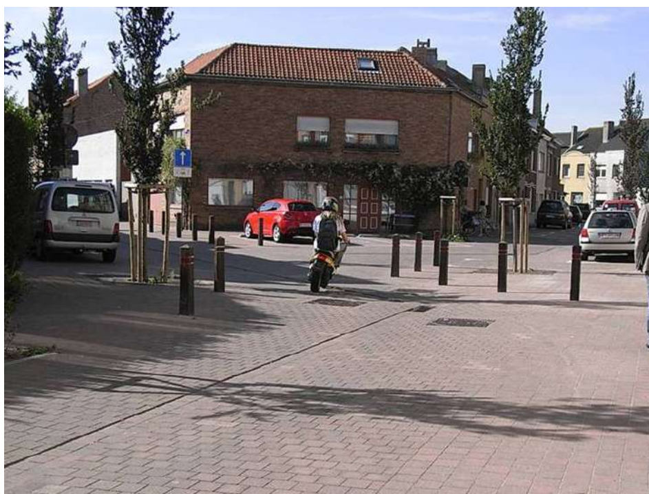
図 4-92 住宅地における整備状況Ⅲ (速度抑制対策の事例)
