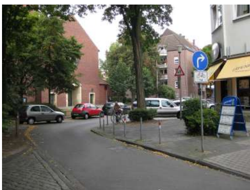
図 4-17 自転車指定方向外進行可（ゾーン 30 内等交差点遮断実施箇所において、自転車は従前通り全ての方向に進行可能としている例）
