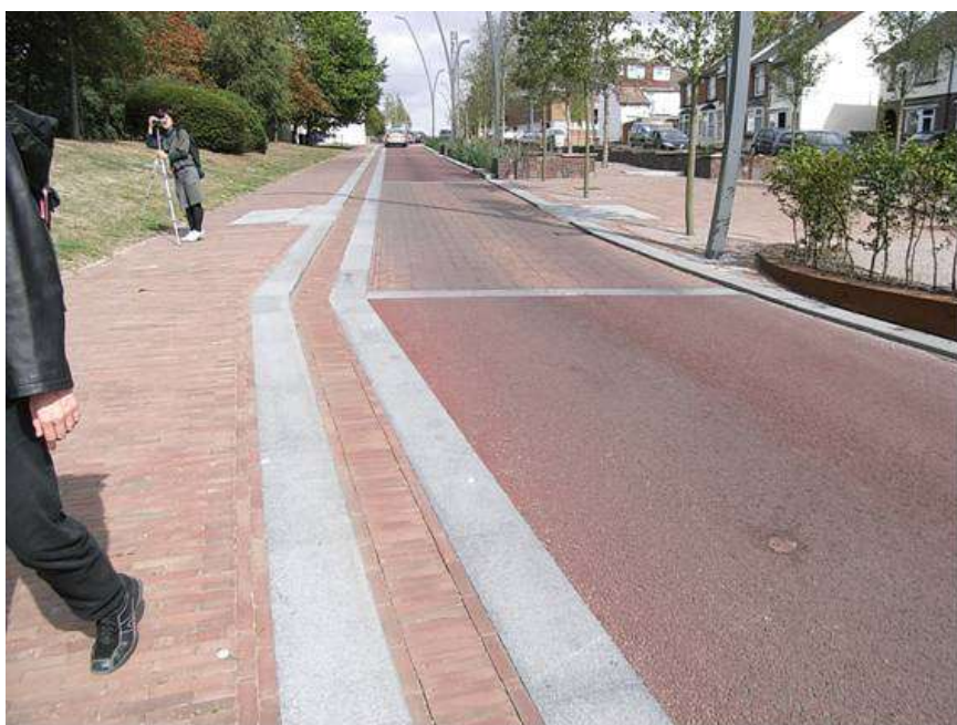
図 4-128 中心市街地西側外沿部の状況（中央分離帯の整備状況）
