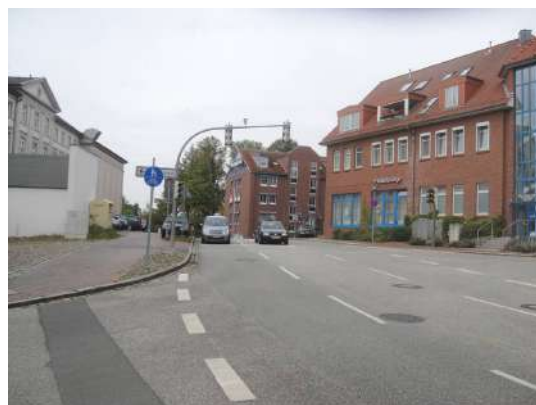
図 4-78 南側地区道路の拡幅済箇所
