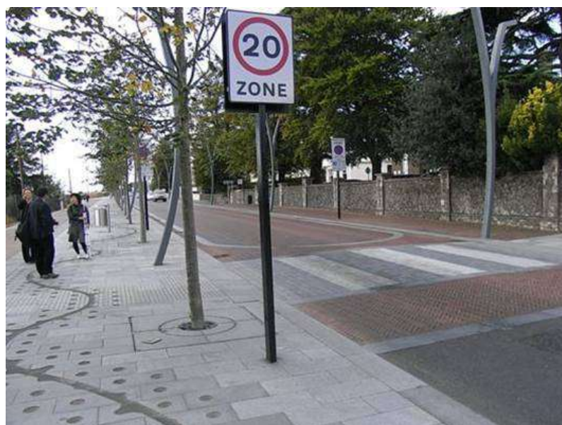
図 4-133 中心市街地南側外沿部シェアスペース整備
