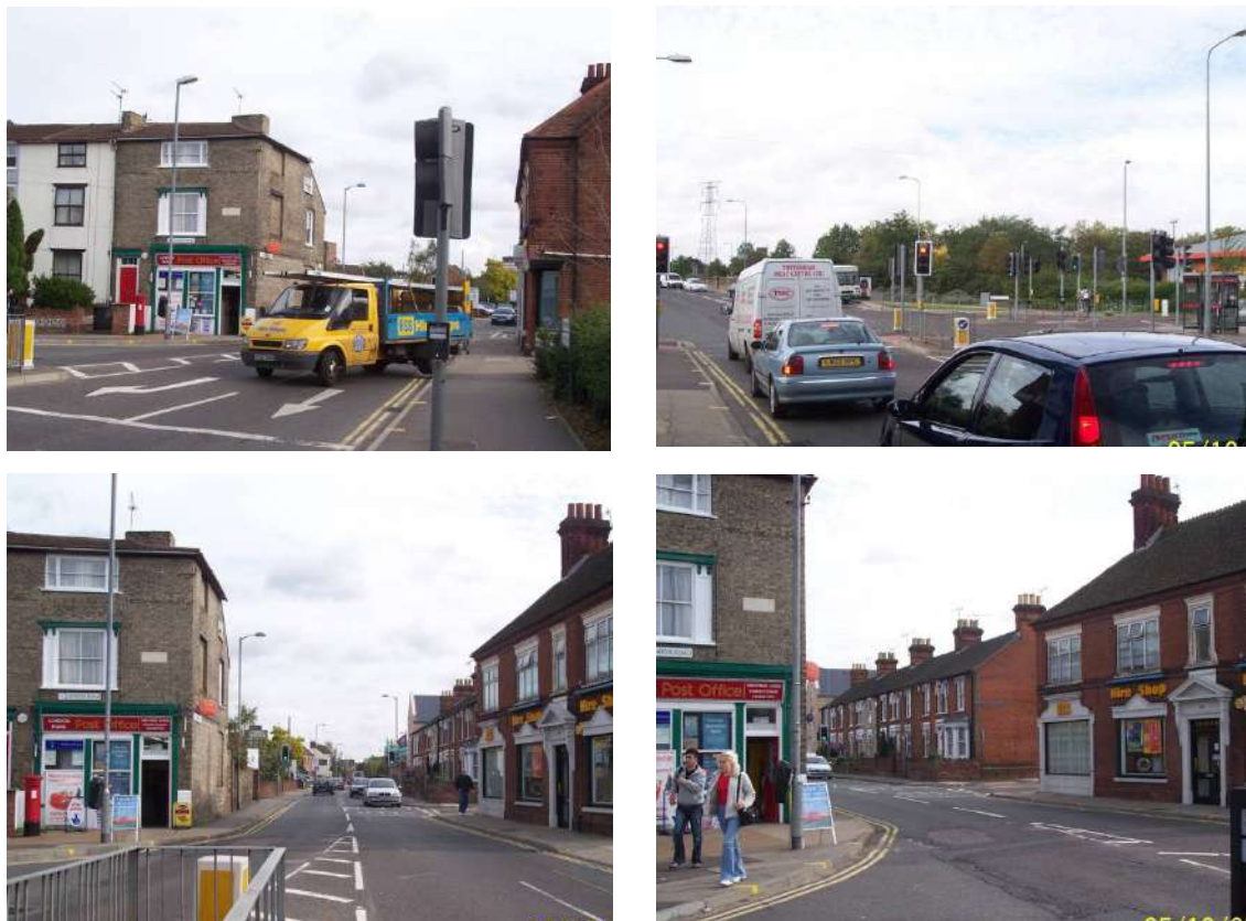
図 4-102 整備前の状況
