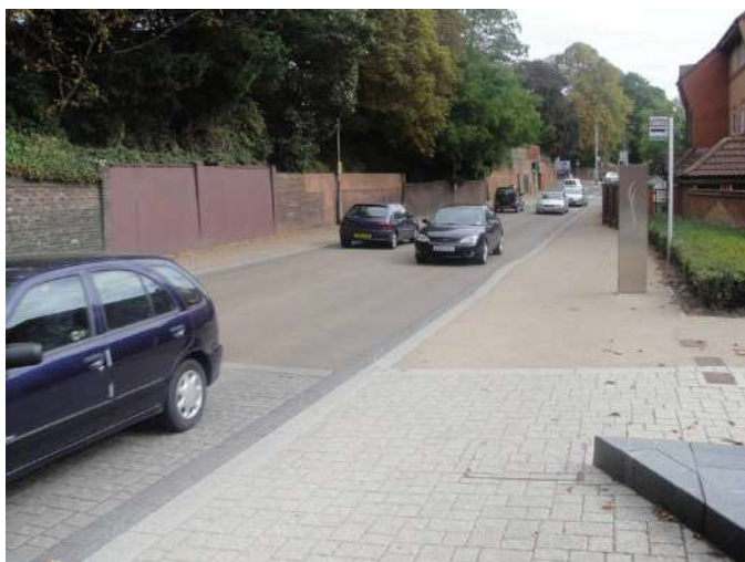
図 4-111 公園前の道路状況 1（整備後）
