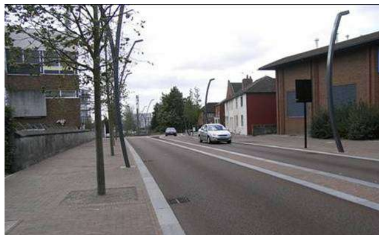
図 4-126 中心市街地西側外沿部の状況（シェアドスペース導入部）
