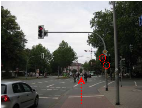
図 4-21 自転車専用信号の活用例 1 (自転車のみを先行して進行させ、右折自転車は、右折車線横の自転車専用右折車線へ誘導。 その後、自動車信号が青となる)
