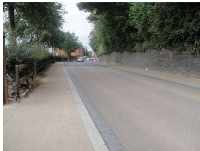
図 4-112 公園前の道路整備状況 2（整備後）
