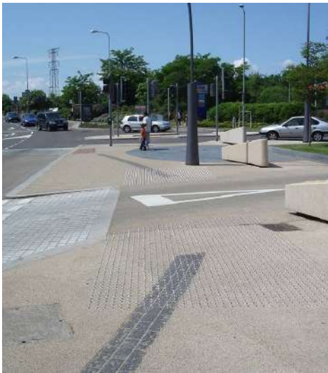
図 4-107 視覚障害者用の誘導ライン（黒）を設置
