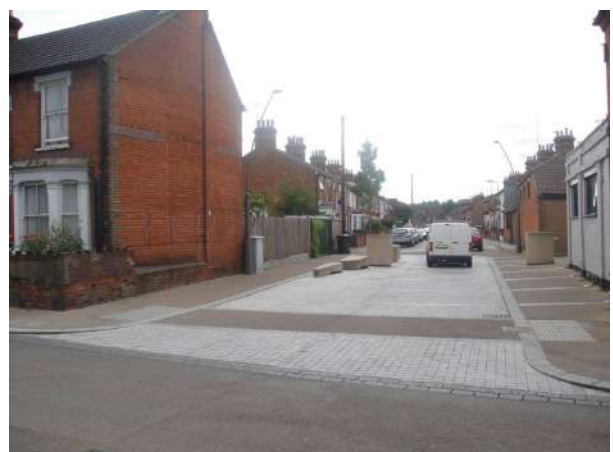
図 4-109 住宅地出入り口整備後の状況
