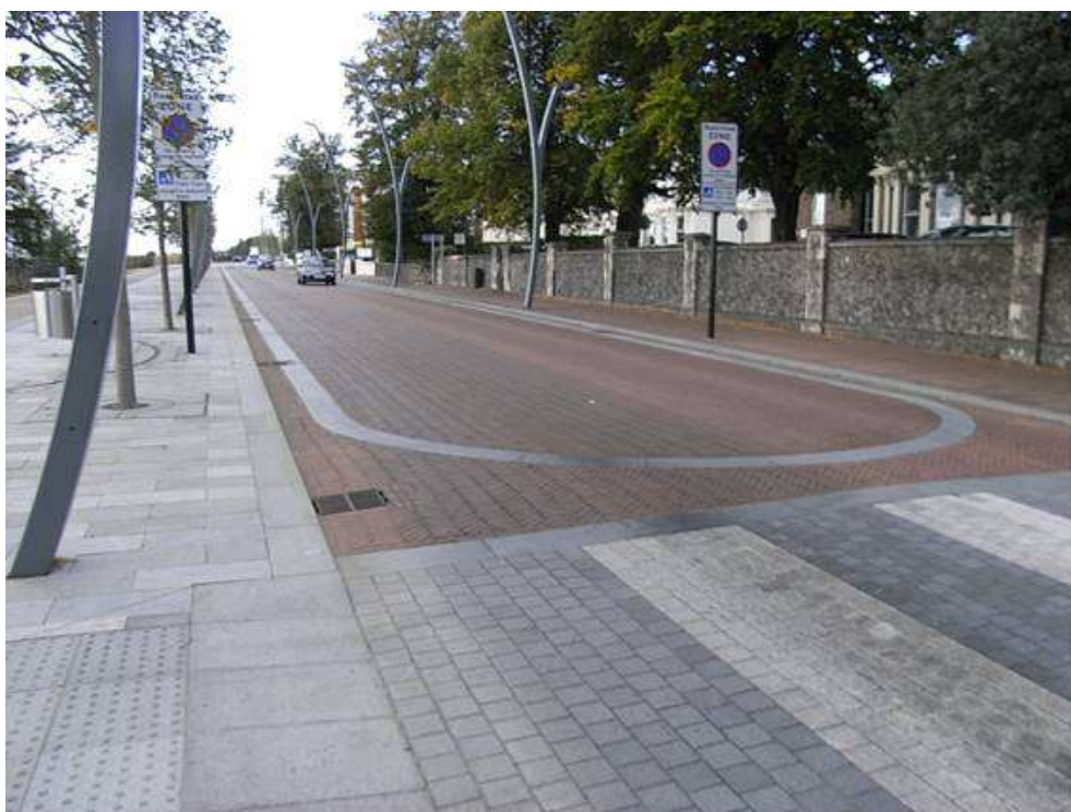
図 4-134 中心市街地南側外沿部シェアスペース整備
