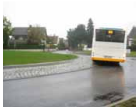
写真-3.3 エプロンを利用する大型車 (ドイツ)
