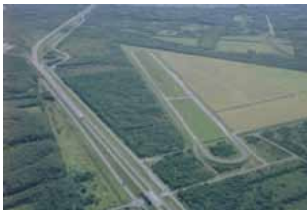
写真-4.1 苫小牧寒地試験道路
