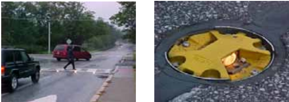
写真-6.2 埋め込みライトの例
