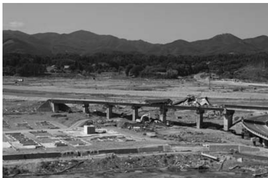
図 5-10 甚大な被害を受けた小泉地区の集落と JR 気仙沼線の高架（2011 年 7 月 11 日に筆者が撮影）
