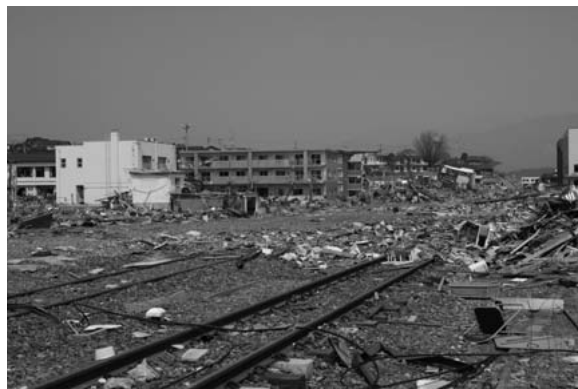
図 5-8 駅舎も壊滅的な被害を受けた大船渡線 の大船渡駅（2011 年 4 月 14 日に筆者が撮影）
