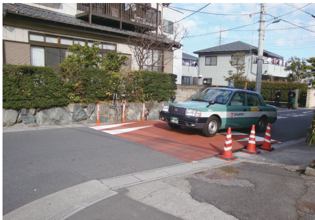
ハンプとは騒音や振動の少ない「こぶ」のような盛り上げ舗装のこと。設置することで運転者の減速を促し、通行車両への高い速度抑制効果が期待される
