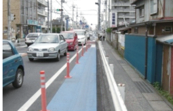
路側帯を広げてカラー舗装し、 自転車走行空間として整備
