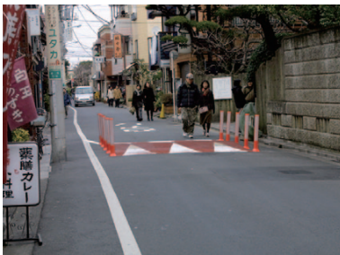
図4 実験的に設置されたゴム製ハンプ。効果や影響について、地域住民が事前に体験し評価することができる。サイン曲線形状により騒音・振動が抑制されている。
