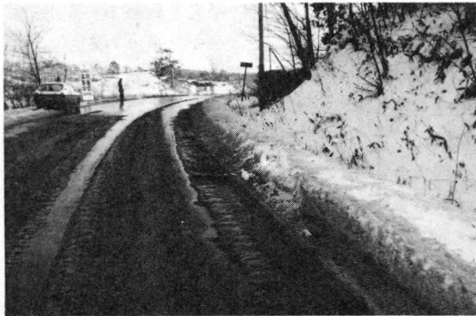
Fig. 6 ダンプ車の進路のわだち(下り坂) (S.54.11.21日撮影) Wheel paths on dumpcar's course
