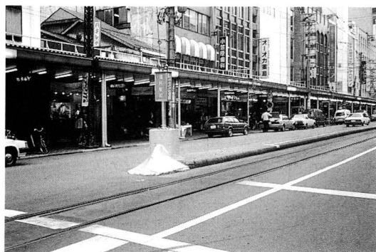
Fig.12 安全島の処置の良い例
