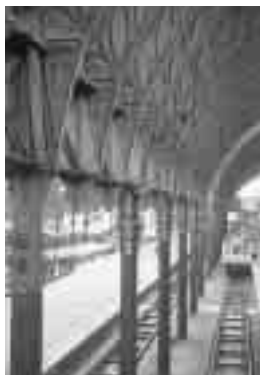
Fig.6 トレイン・シェッド：パディントン駅、ロンドン I.K. ブルネル設計、1854年
