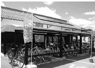
Fig. 5 大手前サイクルポートと太陽光発電パネル 1)
