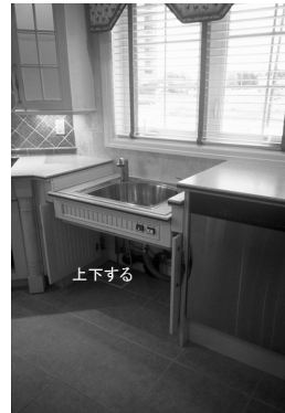
Fig. 9 車椅子利用時に高さが調整できるシンク
