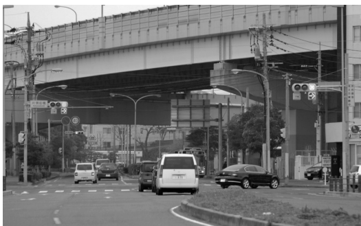
Fig. 11 社会実験を行った福岡市東区片男佐橋交差点。アイランドシティの入口。島全体の設置を目指した。
