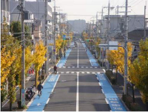
Fig. 1 モデル地区で導入された自転車レーン(兵庫県尼崎市) 180ページ
