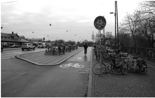
Fig. 5 道路両側一方向の自転車道（コペンハーゲン）
