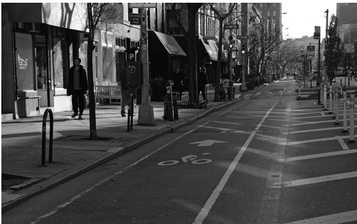
Fig. 12 ポールで簡易分離した事例（ニューヨーク）
