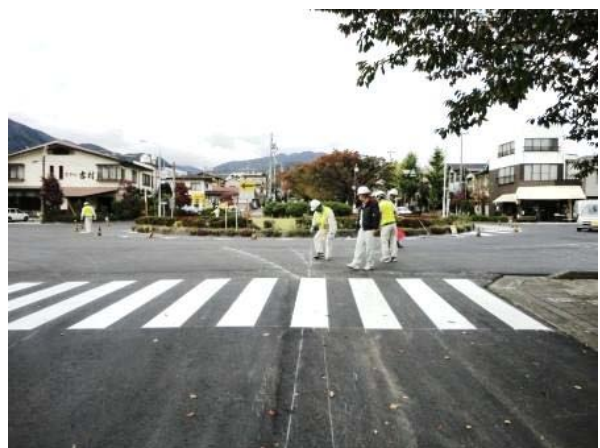
写真-3.5 設置した路面標示(全天候型溶融式路面標示材) 協力：(株)キクテック
