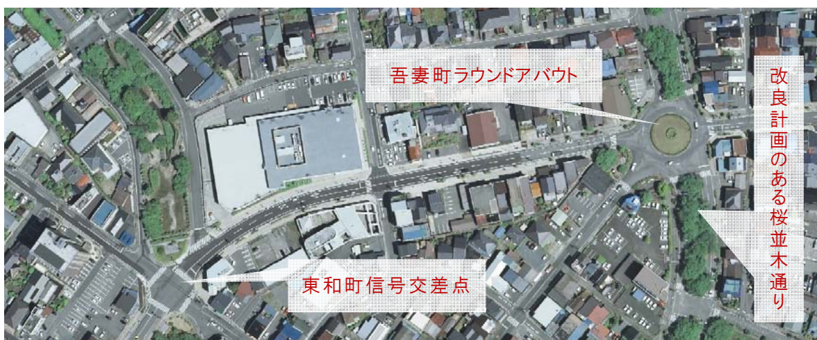
写真-2.1 対象地周辺の上空写真
