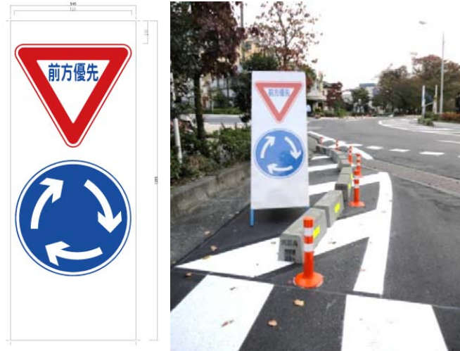
写真-3.8 法定外看板の設置(全流入部)
