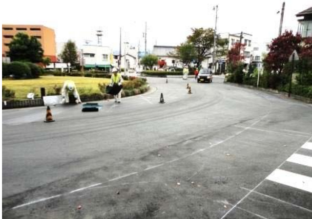
写真-3.5 設置した路面標示(全天候型溶融式路面標示材) 協力：(株)キクテック
