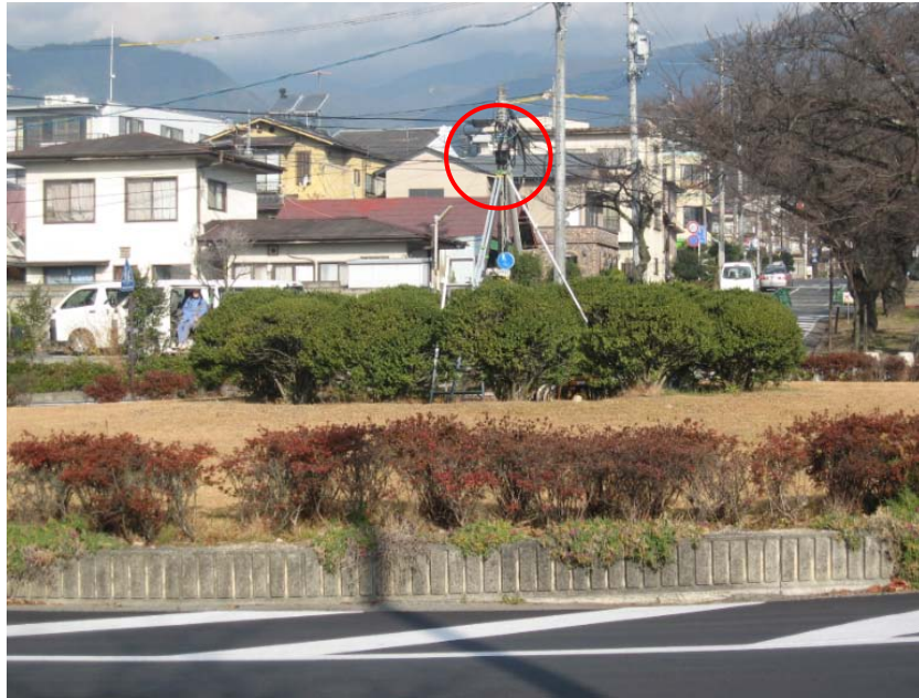
写真-B.4 全方位カメラ設置位置
