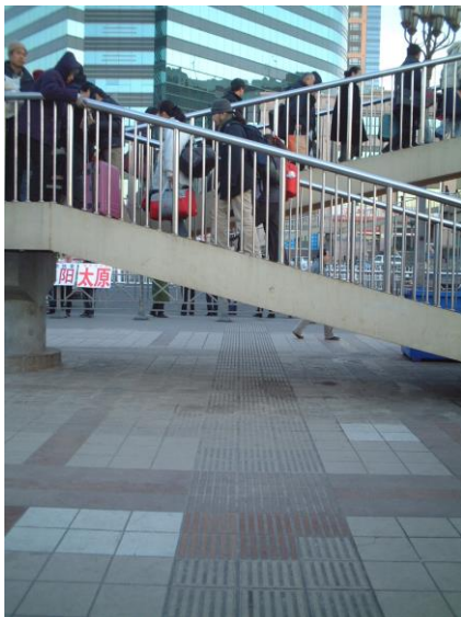
21-3 白杖ではブロックの上の空間にある歩道橋を検知することができないため、点字ブロック上をたどっていくと歩道橋に衝突してしまう。(中国・北京駅前)
