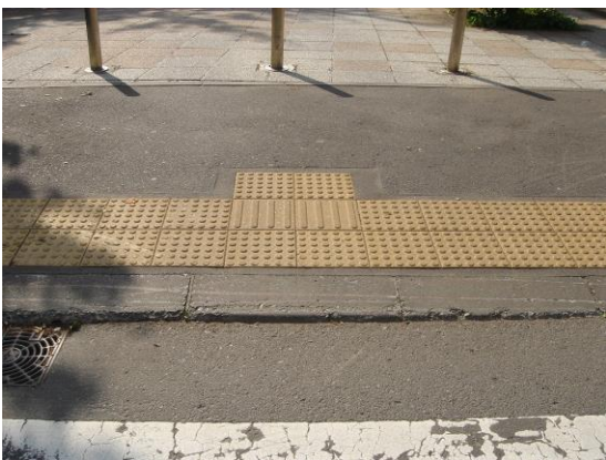
8-4 横断歩道前は通常2列の警告ブロックを設置するのが良い。この写真のように誘導ブロックの先に警告ブロックが1列しかない場合、視覚障害者はその警告ブロックに気がつかず車道に出てしまう、あるいは歩行の勢いがあるため踏み越して車道に出てから停止することになりかねない。改善案のように警告ブロックを2列設置しなくてはならない。（北海道札幌市）
