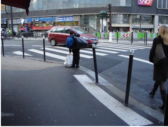
19-2 海外にも日本と同様の誤りがみられる。横断歩道の位置を変更したにもかかわらず、元の場所に点字ブロックがあり、新しい横断歩道前にはない。そのため、横断歩道ではない箇所から道路に飛び出してしまふ危険がある。(フランス・パリ)
