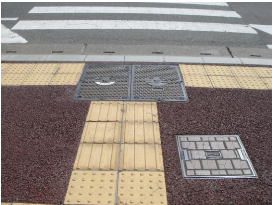
8-3 このケースのように、横断歩道前の警告ブロックを設置しなければならない位置にマンホールがある場合には、マンホールの蓋の上に警告ブロックを設置しなくてはならない。（福岡市）
