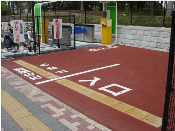
22-3 駐輪場入口の停止線を示すために点字ブロックが用いられている。(茨城県つくば市)
