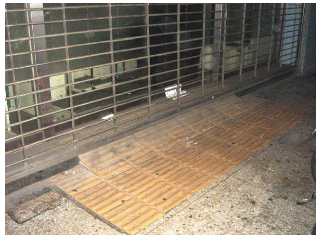
22-2 商店の入口であるが、22-1 と同様に、滑り止めとして用いられている。(台湾・台北)
