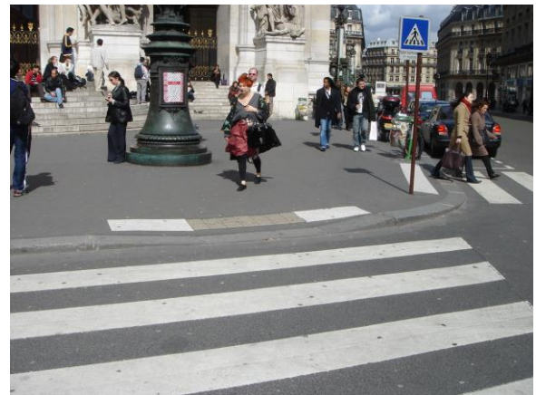
20-9 この写真はパリのオペラ座の前で撮影したものである。元からあったブロックに違う種類のブロックを用いて補修したために景観が損なわれている。(フランス・パリ)
