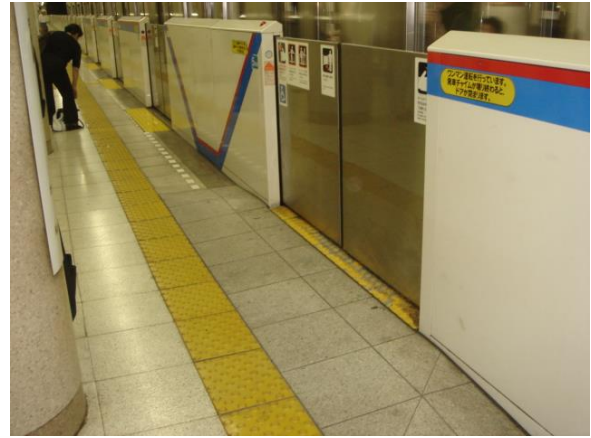
12-4 このようなホーム柵がある場合には、電車への乗り込み口の前、つまりホーム柵のドアがある位置に警告ブロックを設置する。このケースでは、手前のホーム柵のドア部分には警告ブロックが設置されていない。その部分の床は盛り上がり、車いす使用者が電車に乗りやすいように工夫されている。その部分に警告ブロックを設置していないのは、点字ブロックが車いす使用者のバリアにならないように配慮しているからである。（都営三田線春日駅）
