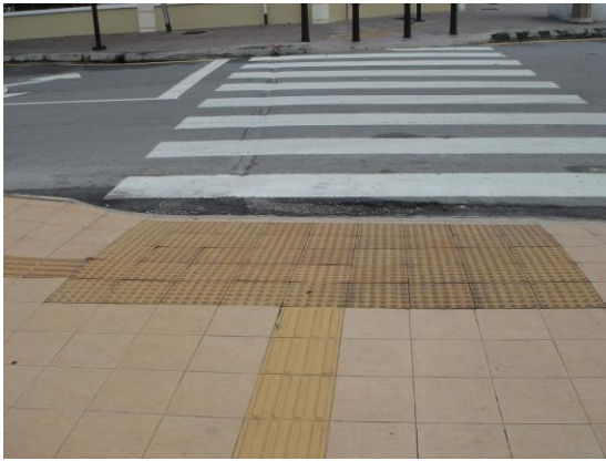
8-11 海外でも横断歩道前に多くの点字ブロックを設置しているケースが目立つ。視覚障害者が迷う原因になる。(マレーシア・クアラルンプル)
