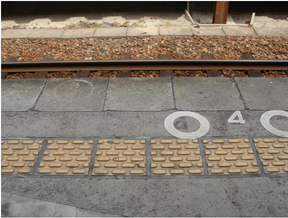
12-3 プラットホーム上に警告ブロックではなく誘導ブロックが設置されているケースである。全国での統一された設置を考えて、警告ブロックを用いなければならない。（JR 奈良駅）
