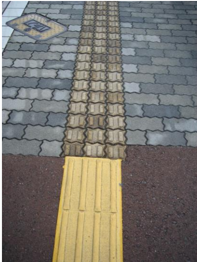
3-3 このケースの2種類のブロックはどちらも誘導ブロックである。上のブロックは警告ブロックに誤認される可能性が高い。 (宮崎市)
