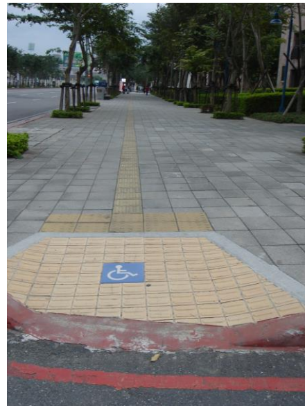
14-8 スロープの全面にブロックが設置してあると、車いす使用者は非常に迷惑する。(台湾・台北)
