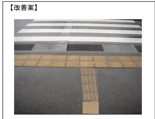
8-2 このケースも誘導ブロックに従って進行していくと車道に飛び出してしまう。改善案のように警告ブロックを設置しなくてはならない。（石川県金沢市）
