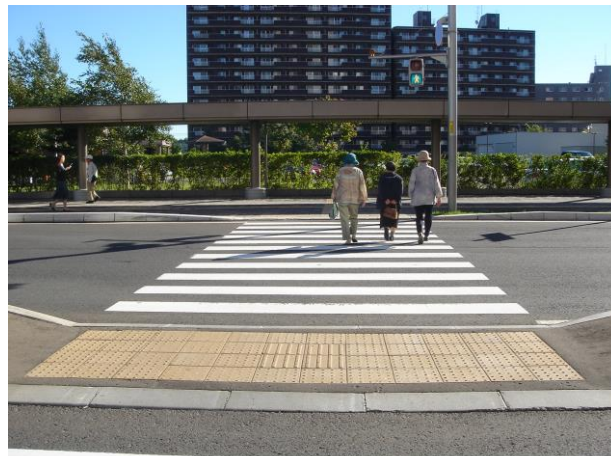
8-13 これは中央分離帯である。大きな中央分離帯では、視覚障害者が道路を渡りきったと誤解してしまうことがあり、きちんとしたルールでブロックを設置することが求められる。このケースのようにブロックを一面に設置することは迷いの原因になる。したがって、次ページの改善案のように横断歩道前は2列の警告ブロック、中央分離帯は1列の警告ブロックを設置するように統一するべきである。(北海道札幌市)
