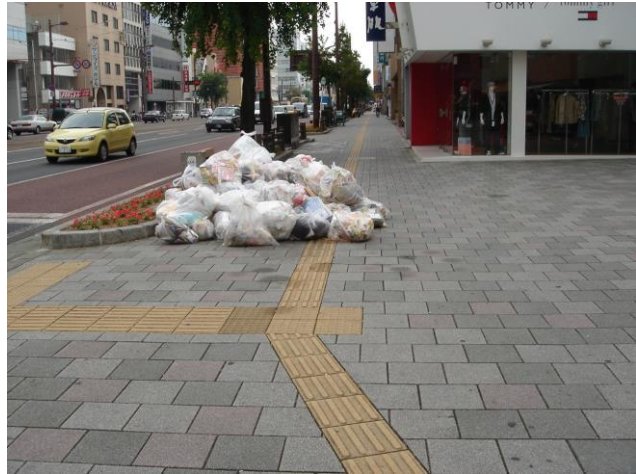
21-10 ごみ置き場の位置を配慮しておかないと、このケースのようにブロックをごみがふさいでしまう。(高知市)
