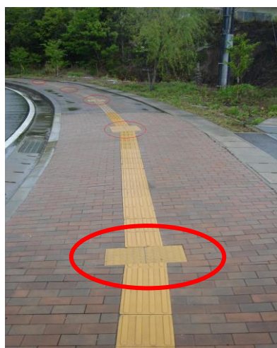
4-2 このケースのように、角度の小さい屈曲部に警告ブロックを設置すると、視覚障害者は何度も立ち止まらなくてはならない。（長崎県対馬市）
