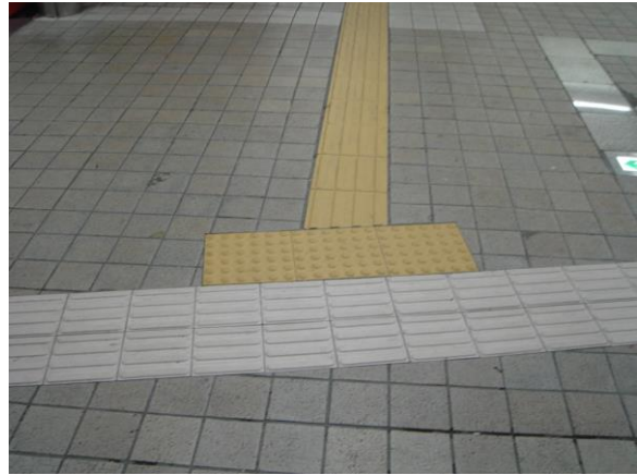
9-5 T字形の交差部分では、このケースのように警告ブロックを設置していることがあるが、左右方向に歩いている（白い誘導ブロックの上を歩いている）視覚障害者は警告ブロックの存在に気がつかない。（韓国・ソウル）
