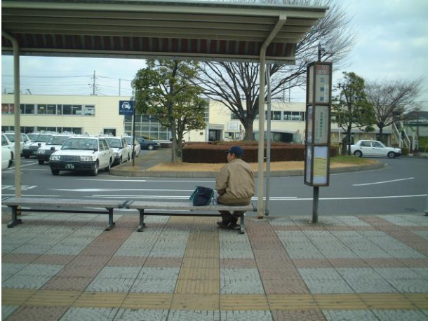
21-1 このケースのように、バス停等で点字ブロックの上にベンチが置かれていることがしばしばある。当然であるが、ブロック上に障害物を置いてはならない。 (埼玉県三郷市)
