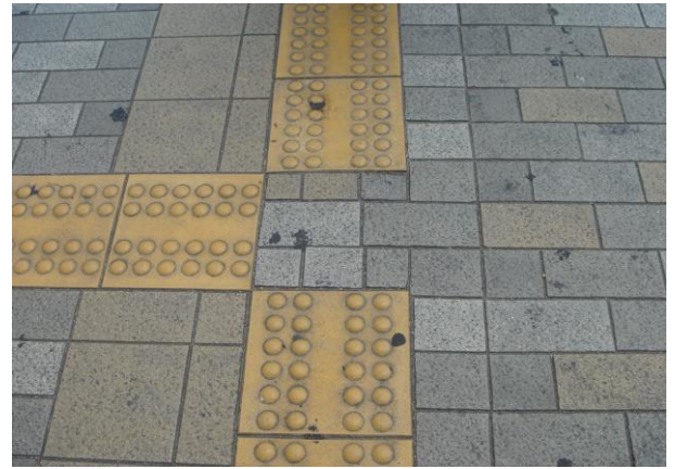
18-2 神戸市内では、18-1 に示したブロックを独自のルールに基づいて設置している。誘導したい方向にこのブロックを設置し、ブロックが交差する箇所や障害物の前等の一般的に警告ブロックを設置すべき場所にはブロックを設置しないで空けておくというルールである。（兵庫県神戸市）
