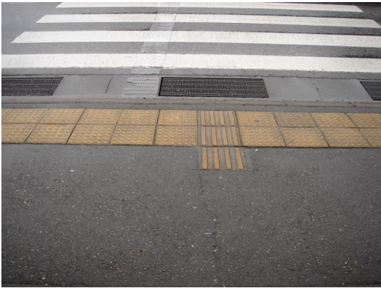
8-2 このケースも誘導ブロックに従って進行していくと車道に飛び出してしまう。改善案のように警告ブロックを設置しなくてはならない。（石川県金沢市）
