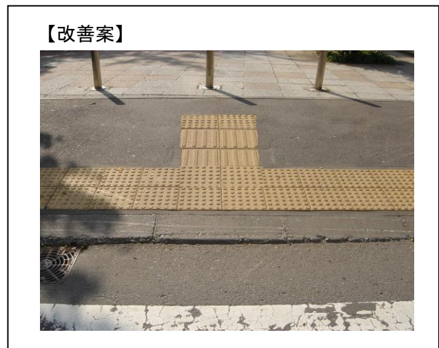
8-4 横断歩道前は通常2列の警告ブロックを設置するのが良い。この写真のように誘導ブロックの先に警告ブロックが1列しかない場合、視覚障害者はその警告ブロックに気がつかず車道に出てしまう、あるいは歩行の勢いがあるため踏み越して車道に出てから停止することになりかねない。改善案のように警告ブロックを2列設置しなくてはならない。（北海道札幌市）
