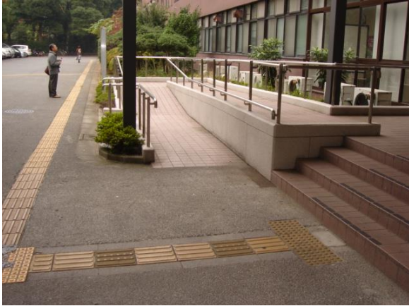
14-2 スロープに点字ブロックを設置するのではなく、このケースのように階段に視覚障害者を誘導することによって、車いす使用者等のバリアの問題を解消することができる。（東京・大塚）
