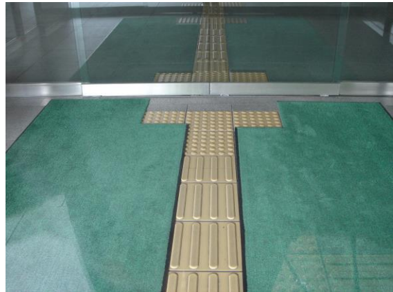
21-6 点字ブロック上にマットを敷くのではなく、このようにブロックの形を残して、ブロックの外側だけにマットを敷くと良い。（広島市）
