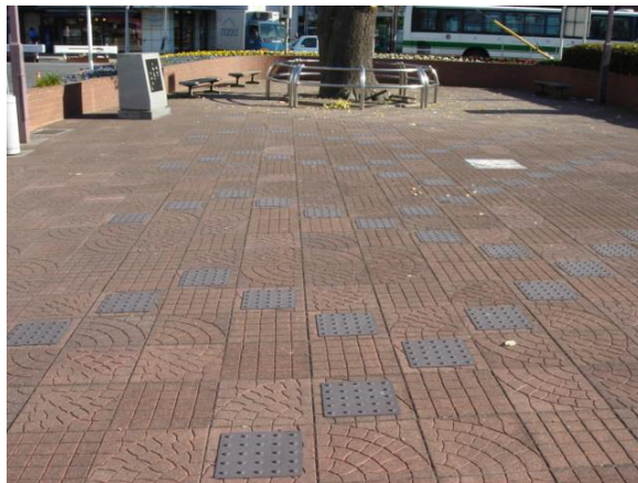
22-5 駅前広場の床面の装飾に点字ブロックが用いられている。(千葉県四街道市)
