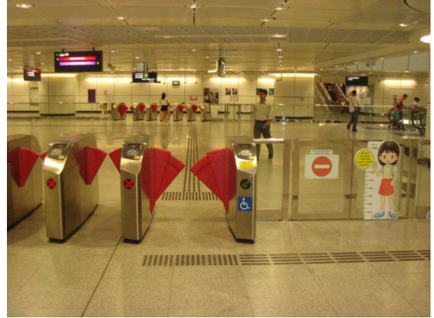
16-4 改札の通路内に点字ブロックを設置していないケースもあるが、改札の始終に点字ブロックが設置されていれば、車いす使用者のバリアになる。(シンガポール)
