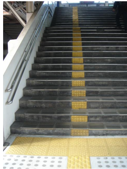
22-4 点字ブロックを階段のけこみ板部分に設置して、上り下りのレーンを分ける線にしている。通常は、この部分に白線が引かれている。(JR 富山駅)
