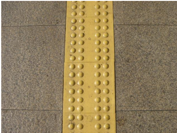
18-1 神戸市内で用いられているブロックである。これは誘導用のブロックであるが、JIS規格の警告ブロックと非常に似た形状である。（兵庫県神戸市）
