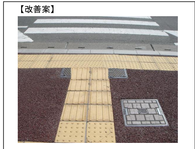
8-3 このケースのように、横断歩道前の警告ブロックを設置しなければならない位置にマンホールがある場合には、マンホールの蓋の上に警告ブロックを設置しなくてはならない。（福岡市）
