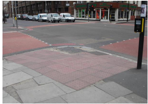
8-12 このケースのように全面にブロックを設置すると、どこが横断歩道であるのか、どの方向に渡ればよいのかがわからなくなる。(イギリス・ロンドン)
