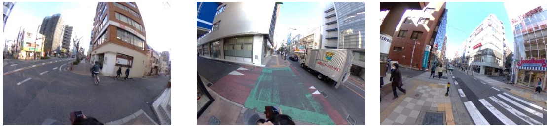
Fig. 43 細街路で歩道が分断される例（左）と舗装で歩道の連続性を示す例（中・右）
